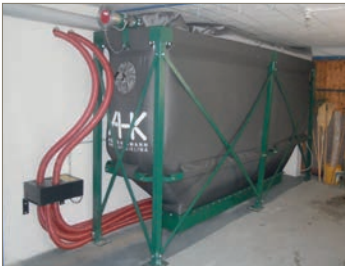
Abb. 14: Trogsilo mit mehreren Saugentnahmepunkten
